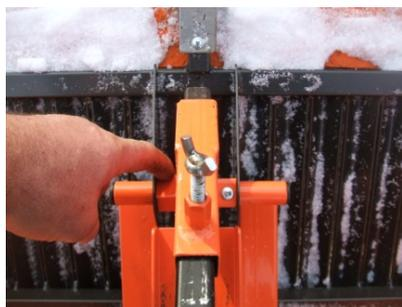
При этом распорные втулки разместите на оси с обеих сторон кронштейна и одну зафиксируйте саморезом (пресшайбой).
